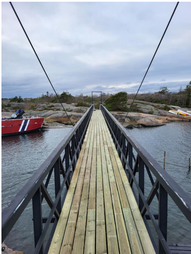
Rakholmen bro har fått utskiftet brodekket.
