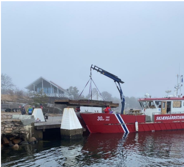
Skjærgårdstjenesten i Hvaler bistod med å frakte en gammel isoporflytebrygge til Tangen og få den på land ved hjelp av kranen deres ombord.
